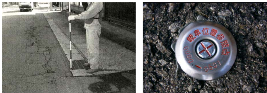
図 6 設置状況写真および標識写真の例
